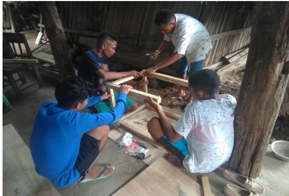
Gambar 3: Mengkonstruksi Bangunan LOPO
